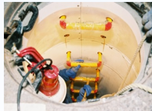
足掛金物設置
