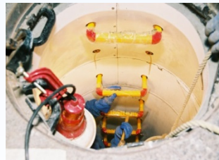
足掛金物設置
